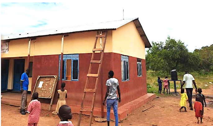
Die selber zusammengezimmerter Leiter ist am Verwaltungsgebäude für das Anbringen der neuen Blitzableiter angelehnt.
